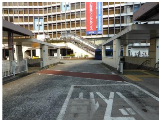
<上屋が途切れている様子(新宿駅)>
