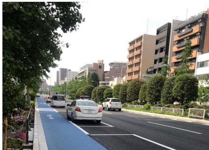
都内における普通自転車専用通行帯の右側に駐車枠を設置した例 (白山通り)
