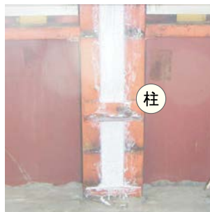
柱の耐火被覆材の封じ込め
