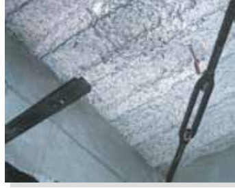
例) 石綿含有吹付けロックウール
