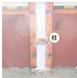
柱の耐火被覆材の封じ込め
