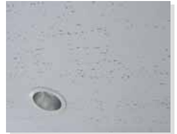
例) 石綿含有吸音板
