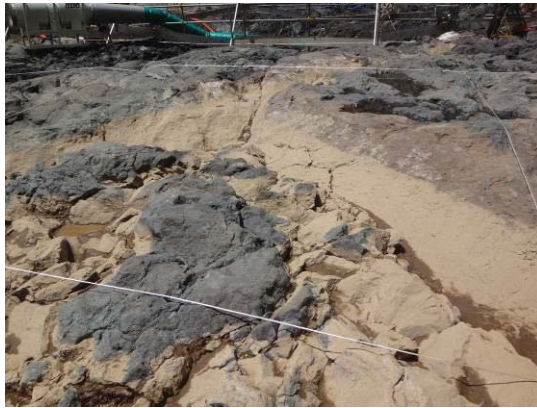
本体基礎掘削状況の確認
