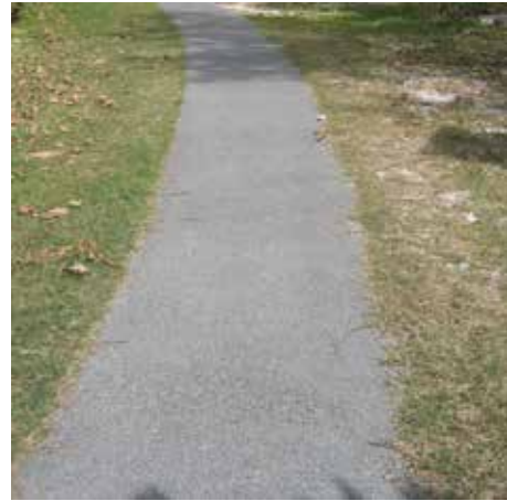
■コンクリート洗い出し舗装（種石：自然石）
