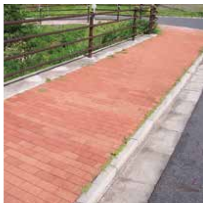
■歩道部のブロック舗装
