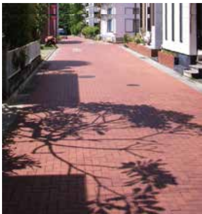
■村道部のブロック舗装
