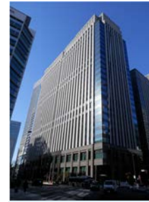
写真① 施設の外観
