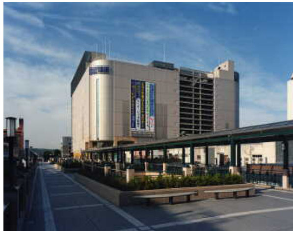
駅南口第 2 地区第一種市街地再開発事業
