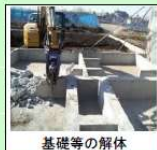
基礎等の解体
