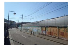
農薬飛散防止施設の設置
