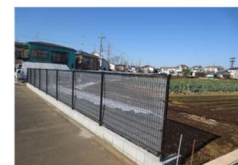
土留め、フェンスの設置
