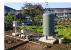
防災兼用農業用井戸の設置
