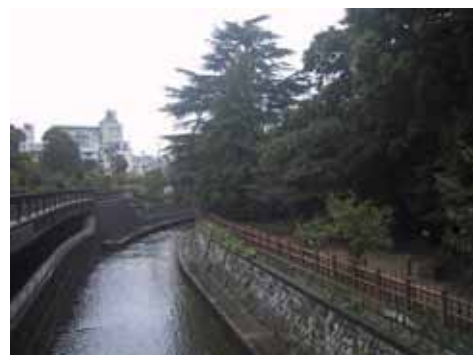
公園と河川による良好な環境 写真左側は、洪水時の調節池流入口 (野方公園、妙正寺川：中野区)
