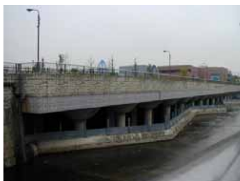
◇洪水調節池の整備と公園が連携している例（壁面に開いているのは取水口）（左 比丘尼橋下流調節池と大泉町公園（大泉橋戸公園）：練馬区 右 落合調節池と落合公園：新宿区）
