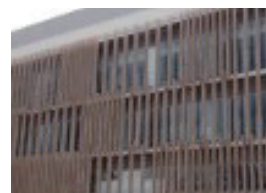
冷却ルーバーの事例
