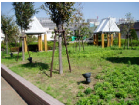
公共施設の屋上緑化 (東京食肉市場：品川区)
