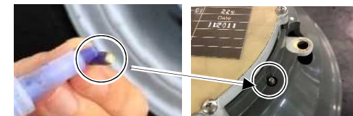
緩み止めを塗布
