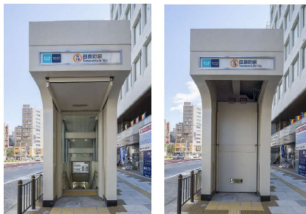
図 4-27 防水機能を備えた管理シャッターを付けた出入口（東京メトロ田原町駅）
