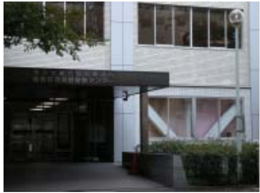
都立庁舎の改修事例
