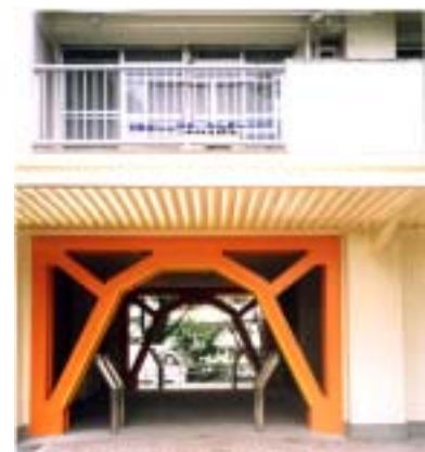
共同住宅の耐震改修の実施例
