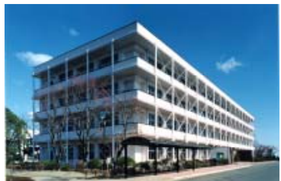
私立学校で耐震改修を実施した例 1
