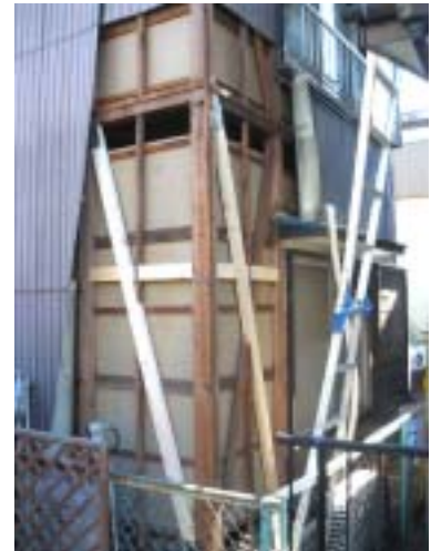
木造住宅の耐震改修の実施例
