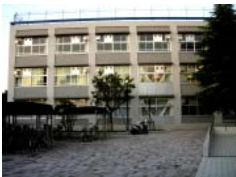
都立施設で耐震改修を実施した例
