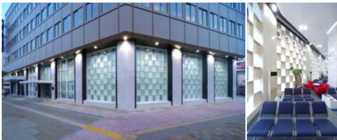
グリッドを基調とした採光性・デザイン性に優れた補強(1階部分)の例
