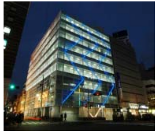
補強に用いた鉄骨をライトアップし、耐震改修したことを積極的に見せるデザインの事例
