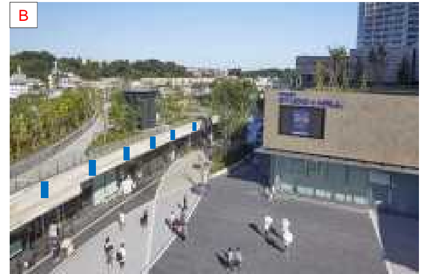
B視点、C視点、D視点共に適用除外区域を見直すことにより、連続したバナーを設置することができ、商業施設として魅力のある演出が可能
