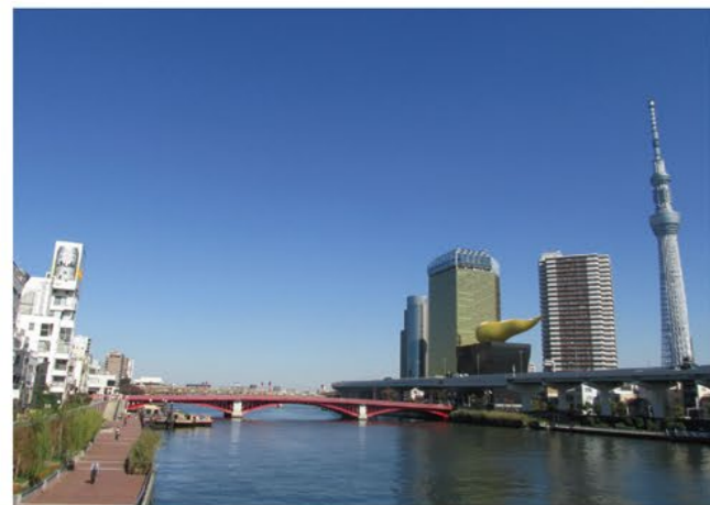
吾妻橋(駒形橋から)
