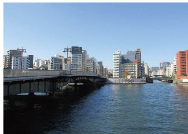
両国橋北側(両国側から)
