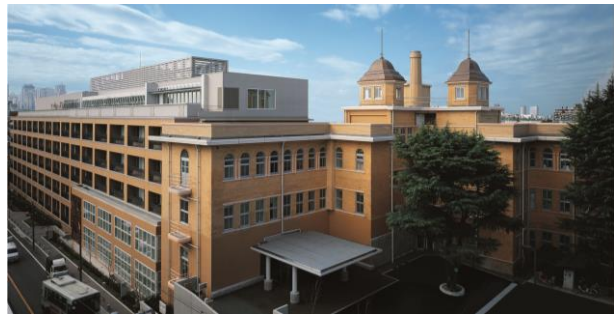
修繕事例 聖母病院
