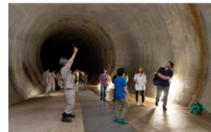
古川地下調節池
