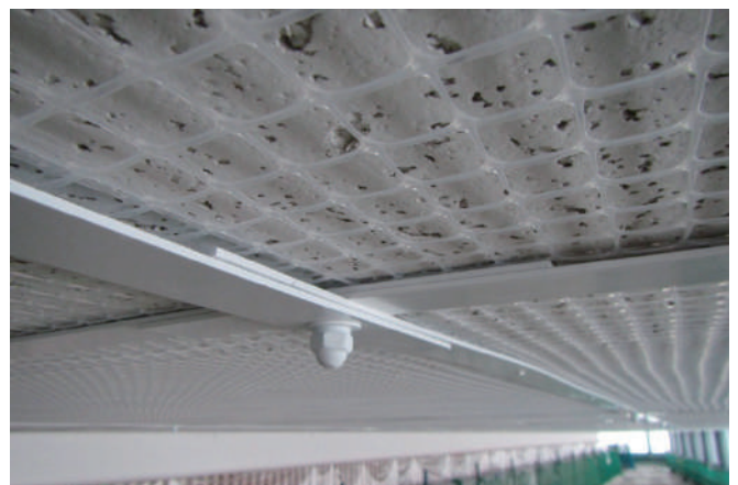
ネットによる落下防止措置
