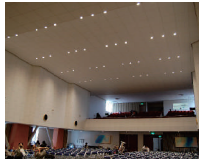
改修後のフラット天井
