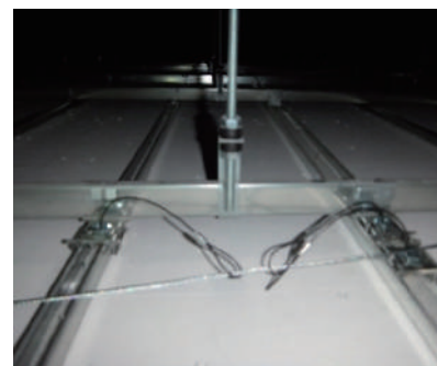
天井裏の施工状況
