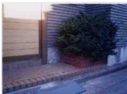
手すり取りはずし時
