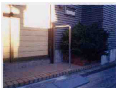
手すり取り付け時
