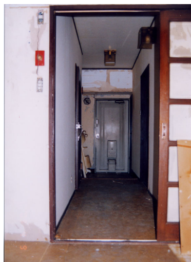
室内から玄関を見た写真
