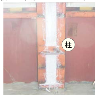
柱の耐火被覆材の封じ込め
