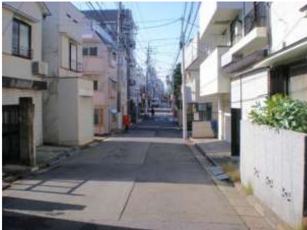
⑦ 木造住宅も数多く建ち並んでいる区画道路7号 (現況幅員 4.2~5.4m)の様子
