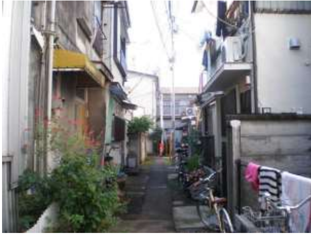
⑫ 街区外側の不燃化が進む中で、建替えの進まない行き止り道路に面した建築物群
