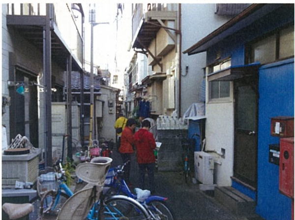
⑦細街路に面して密集する老朽木造建築物
