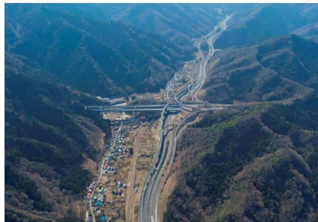
八王子JCT付近の状況
