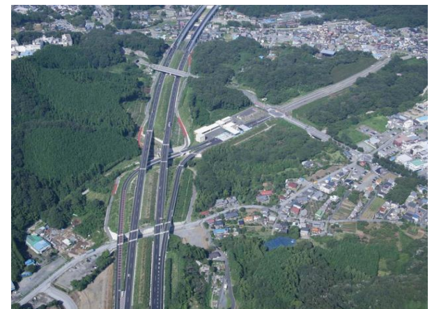
八王子西IC付近の状況
