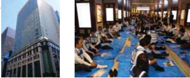
BCP対応オフィスビル
