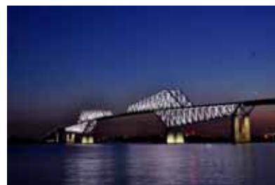
東京ゲートブリッジ
