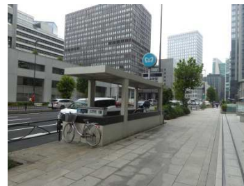
大手町駅 広場・たまり空間のない地下鉄出入口
