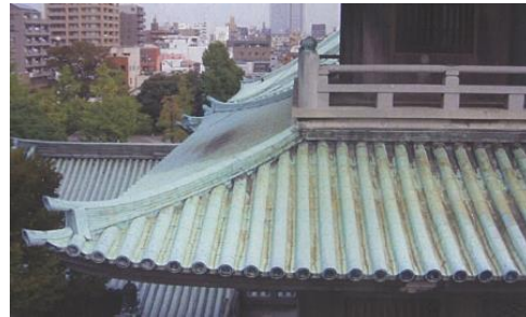
改修前屋根部（届出資料より）
