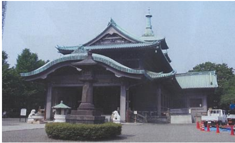
改修前外観（届出資料より）
