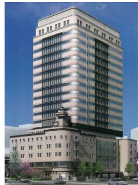
部分建替え時外観（ビルパンフレットより）
