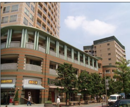
多様な外装材によって構成される建築物の外観
