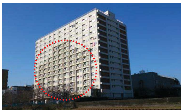
【耐震ブレースによる補強】
