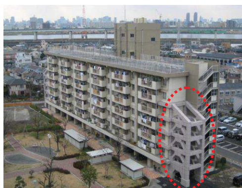
【建物妻面にバットレスを設置】
