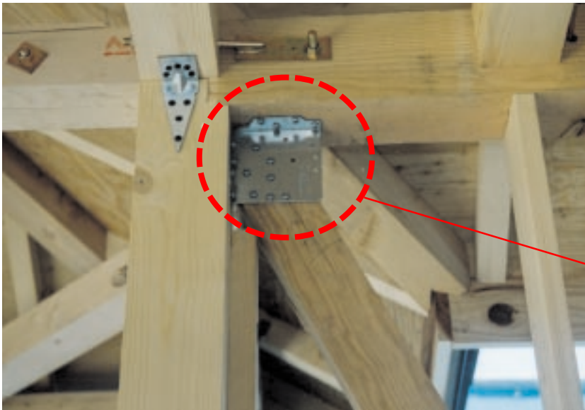
写真タイトル：筋かい接合部詳細
