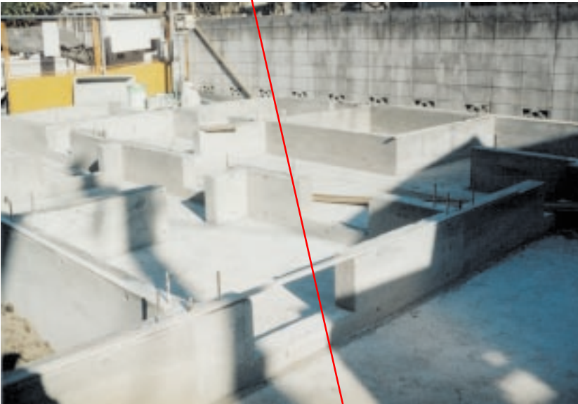
写真タイトル: 基礎コンクリートの型枠を外した直後の写真
