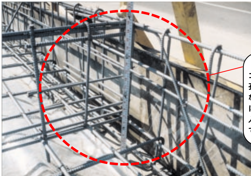
写真タイトル：基礎鉄筋コーナー部詳細
