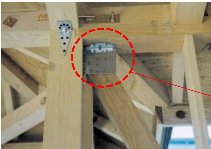
写真タイトル：筋かい接合部詳細
