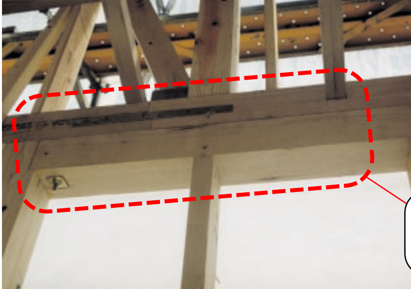
写真タイトル：横架材の補強詳細
