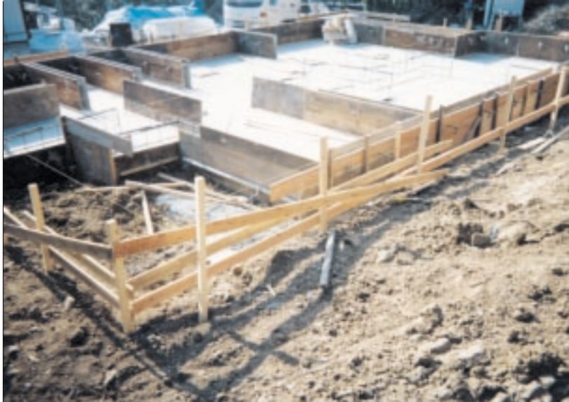
写真タイトル: 基礎コンクリート打設直前の全景
