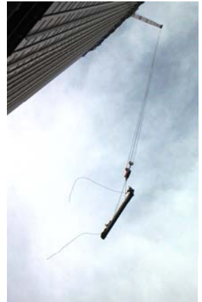
引き上げられる大梁
