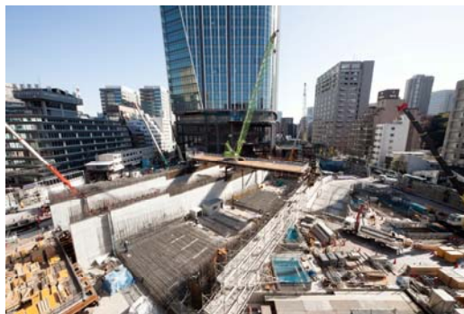
平成24年12月 Ⅲ街区立体道路の工事状況
