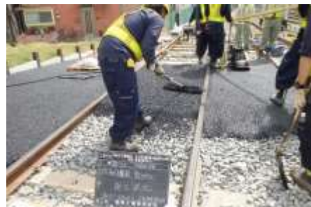
踏切工(舗装 施工)
