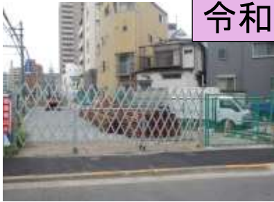
安全設備設置(ゲート)
