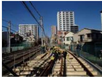
仮線路敷設工
