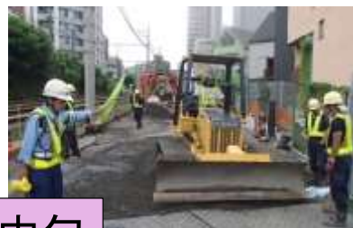
整地工(路盤整正)
