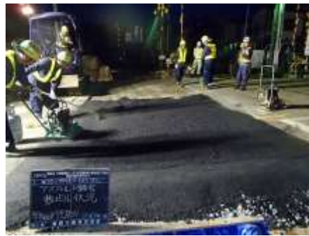
切替 舗装工事 (切替工事時は夜間)
