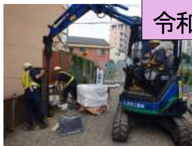
土留工(施工中)
