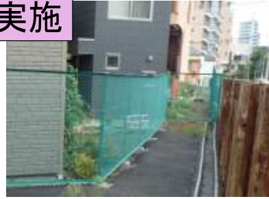
安全設備設置(フェンス)
