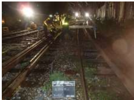
切替 線路工事
