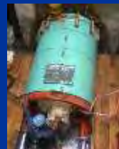
設置状況(発信立坑上部より)
