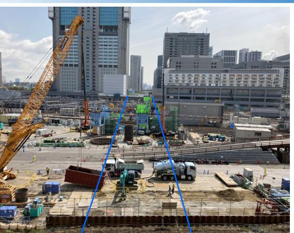
高輪方から見た鉄道区域での施工の様子（4月下旬撮影）。橋を支える柱（橋脚）の基礎をつくっています。（青色の線は将来の橋のおおよその位置）
