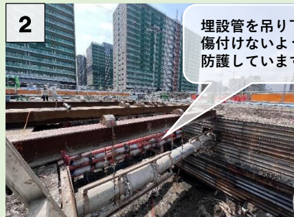
防潮堤撤去の状況 (吊り防護)
