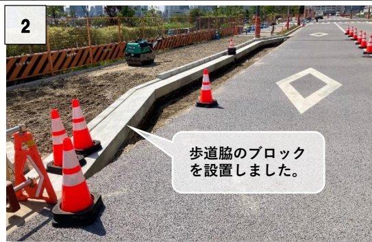
歩道脇のブロック整備状況（区画道路5-4号線）
