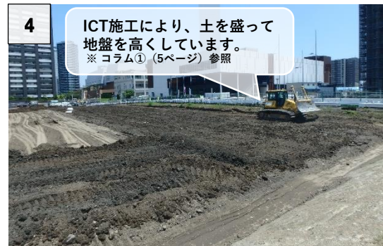
盛土の整備状況（マルチモビリティステーション）
