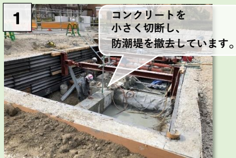
防潮堤撤去の状況 (コンクリート切断)
