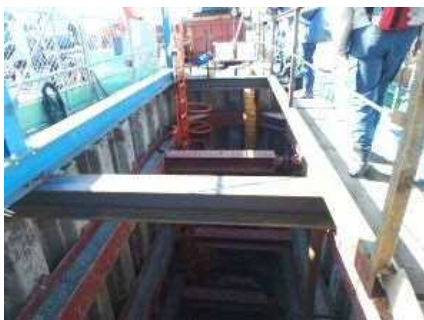
晴海西幹線の発進基地の立坑を設置しています
