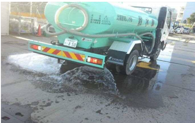
散水状況 ひさんぼうし (飛散防止対策)
