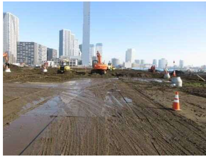
道路の盛土工事を行っています （5-3号線）
