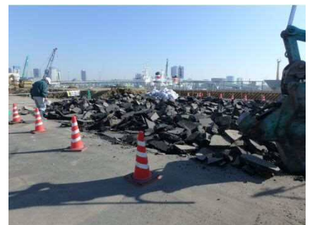
舗装などを撤去しています （5-1号線）
