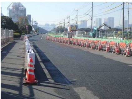
規制帯を設置しました（5-4号線） （仮設道路から客船ターミナルを望む）
