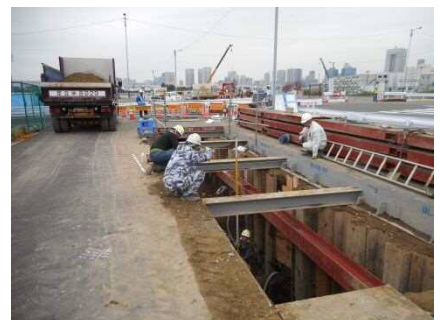
補助第 314 号線の歩道部で下水道管を新設しています
