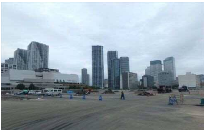
解体工事着手前状況 (10月初旬)
