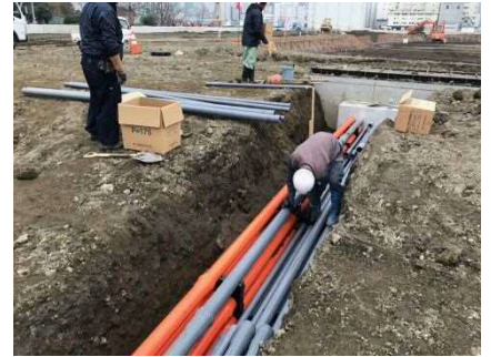
電線共同溝の設置を行っています （5-4号線）
