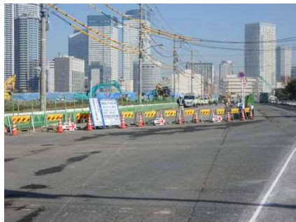
規制帯を設置しました（5-4号線） （客船ターミナルから仮設道路を望む）
