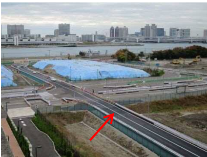
仮設道路に通行路を切り替えました
