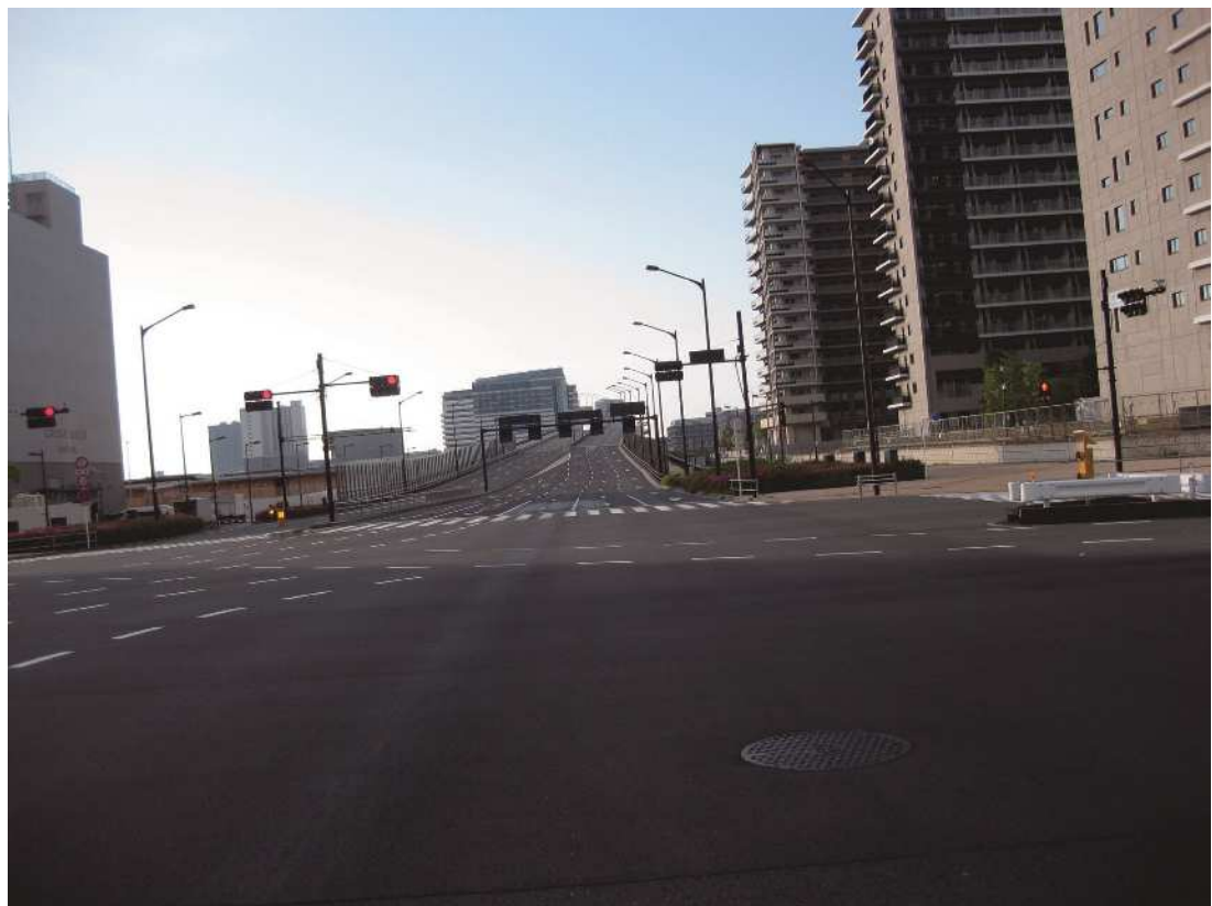
環状第2号線（晴海5丁目交差点～豊洲大橋間）
