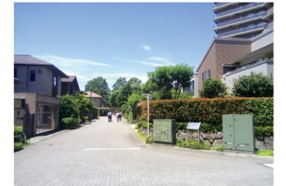
民間宅地開発における無電柱化の事例
