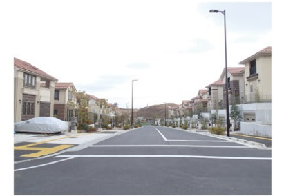
区画道路の無電柱化の事例 稲城市 東長沼 南山東部地区
