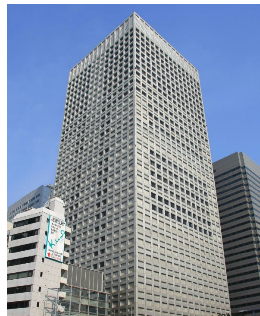
⑧西新宿二丁目(3号地) | KDDIビル 引用: https://www.blue-style.com/building/KDDI%E3%83%93%E3%83%AB
