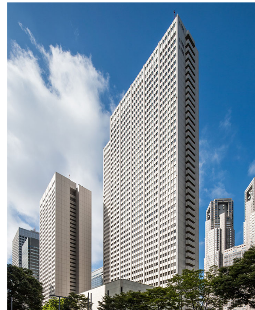
④西新宿二丁目(6号地) | 京王プラザホテル 引用: https://www.nihonsekkei.co.jp/projects/2003/
