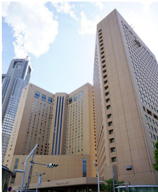
①西新宿二丁目(7号地) | 小田急第一生命ビル 引用: https://www.officetar.jp/building/1224/3297/
