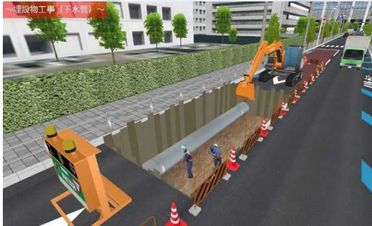
既設埋設管の撤去工事
