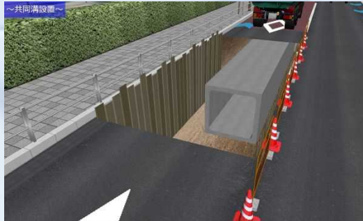
共同溝の設置
