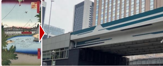
KK線で実施されるカラーリペイントプロジェクト※11
