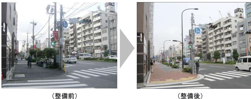
図 4-15 自転車通行空間の整備事例(墨田区業平、浅草通り)
