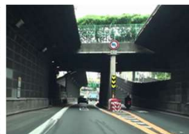
図5 車道内橋脚(都心環状線内回り)
