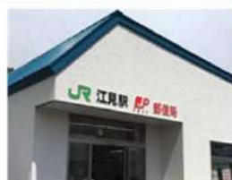
駅舎の 新改築・移設
