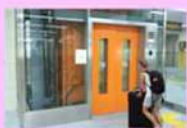
・段差解消 (エレベーター)
