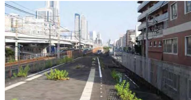
出典：「平成27年度第1回横浜市公共事業評価委員会東横線跡地整備事業（廃線区間）平成27年11月10日（火）横浜市」掲載写真を抜粋 https://www.city.yokohama.lg.jp/city-info/zaisei/kokyo/jigyohyoka/h27/h27-1linkai/files/0006_20180718.pdf
