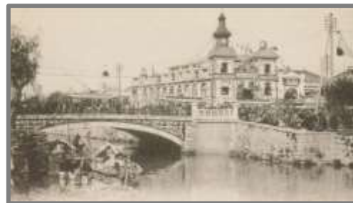
汐留川に架かる蓬萊橋 奥には勸工場の博品館
